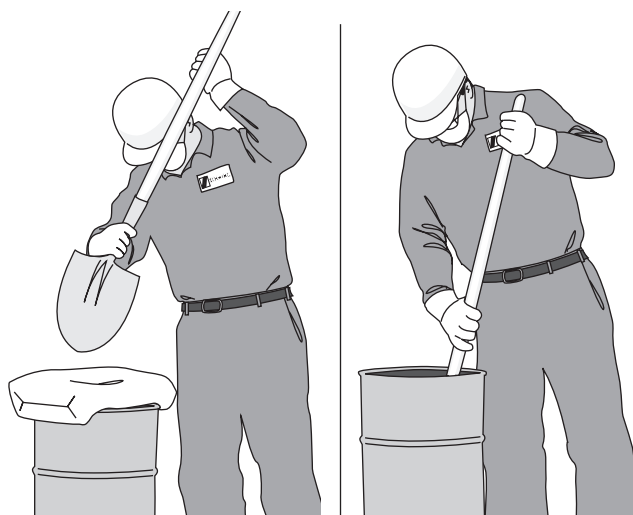
Figura 16 Mezcla de la lechada en un barril
