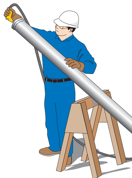
Figura 23 Lavado del sistema de tubos
